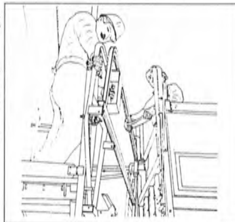
Obr. 28 Montáž výstupu do patra
